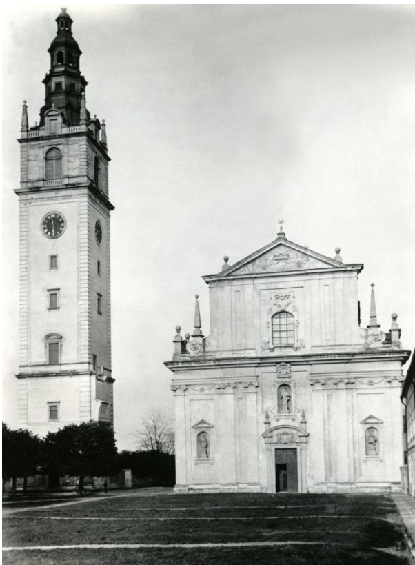
Katedrála sv. Štěpána s již dostavěnou věží, po roce 1890. Věž není ještě propojena spojovacím obloukem s katedrálou. Raně barokní katedrála sv. Štěpána byla vystavěna v letech 1663 – 1670. Věž u katedrály vznikla později (v letech 1883-1889), dnes funguje jako vyhlídka.
