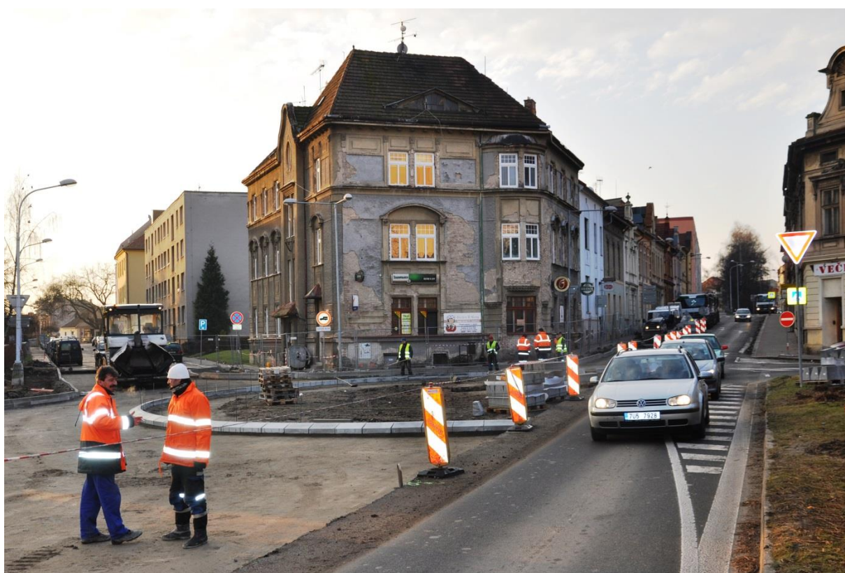
Foto č. 1,2 - V rámci příprav na rekonstrukci Tyršova mostu byl rekonstruován kruhový objezd na křižovatce ulic Na Valech, Liškova, Mrázova a Č. Armády – únor 2015.
