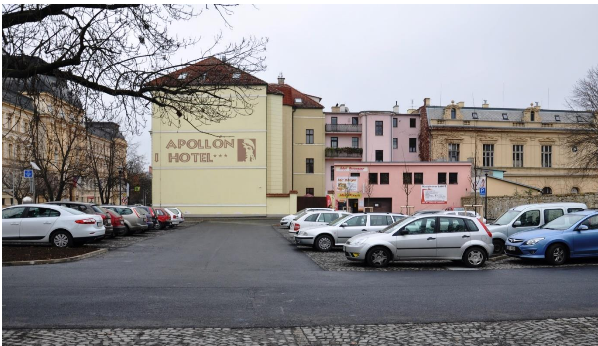
Foto 16, Dokončení nového parkoviště pro 45 vozidel v ulici Na Valech.
