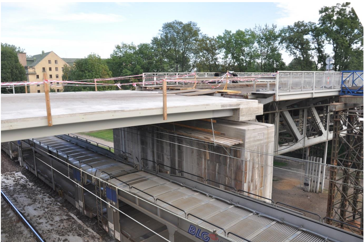
Foto 3 – 8, Rekonstrukce Tyršova mostu v průběhu roku 2015
