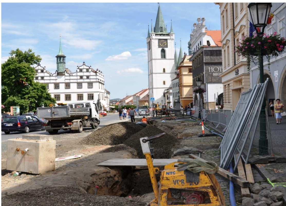
Foto 11 a 12, Rekonstrukce vodovodu a plynovodu na Mírovém náměstí.
